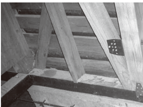
木造住宅耐震改修の様子
