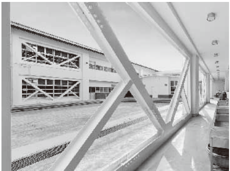
23年8月に完成した内子小学校耐震化
