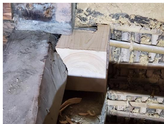
◀左：加工前の木材。◀右：元々の木部の角度を写し取りながら削っていきます。
