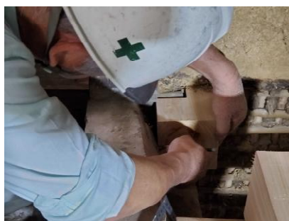
◀左：加工前の木材。◀右：元々の木部の角度を写し取りながら削っていきます。
