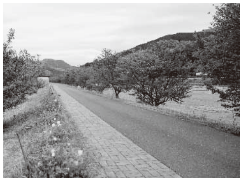
山王橋までの堤防上の道路
