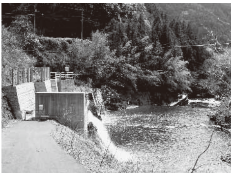
高知県橋原町の小水力発電設備
