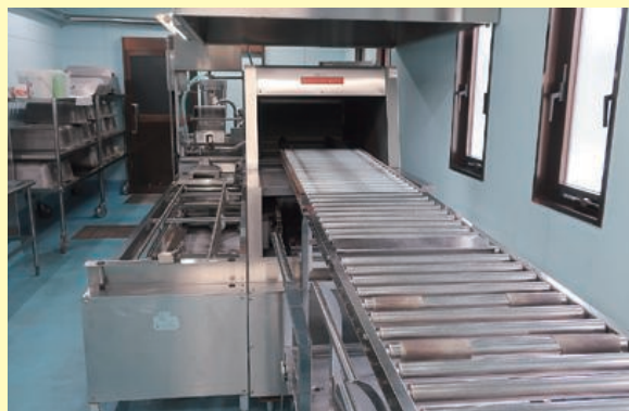
現在使用している内子学校給食センターの連続炊飯システム
