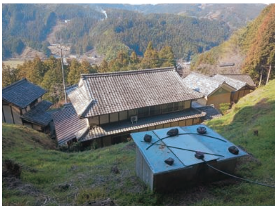
個人で設置した水道施設
