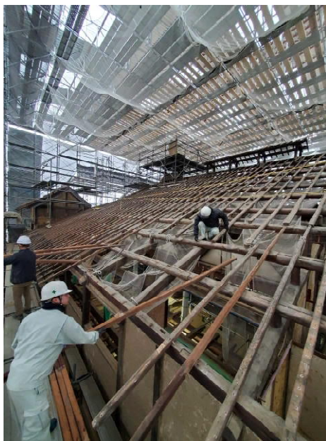
▲一部に腐食が見られる軒桁
