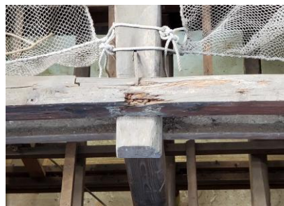
▲一部に腐食が見られる軒桁
