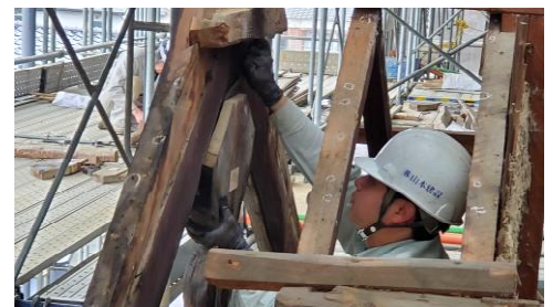
▲東櫓の懸魚解体作業の様子
