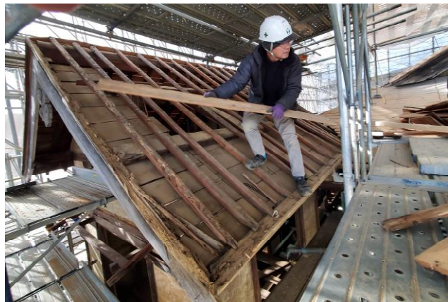
▲西檜の野地板解体の様子
