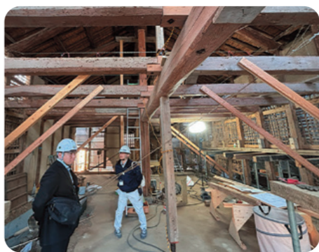
2期工事のようです。完成が楽しみです
