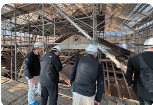
瓦や壁を取り除いた状態の内子座
