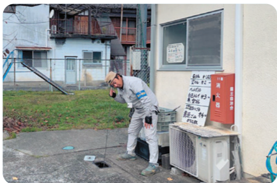
音調棒を使った漏水調査の様子
