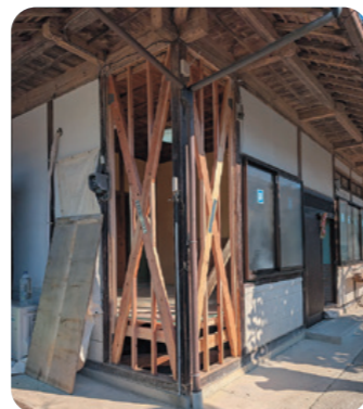
木造住宅耐震改修工事
