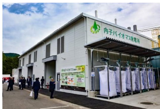
内子バイオマス発電所
