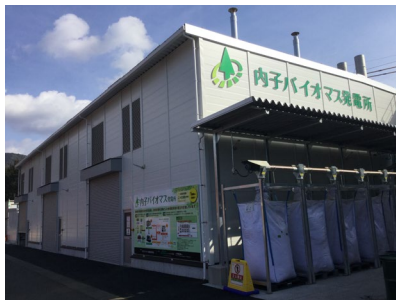
内子バイオマス発電所
