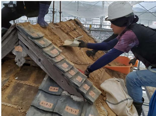
瓦とともに作業しなければならないのが土の処理です。屋根の場所により厚みもそれですが、およそ3cmの厚みの土を落とさないよう袋に詰め、屋根から下ろす作業も力のいる仕事です。
