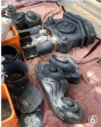
の”雲水”部分、④右側の”雲水”部分を取り外し、⑤最後に紋章のついた顔ともいえる部分を取り外します。どの部分も重いのですが、最後は一段と…。大人二人で抱えるのがやっとでした。⑥取り外された鬼瓦。写真では迫力が伝わりませんが、横幅が約1,850mm、高さは1,040mmもあります。内子座一の鬼瓦です。
