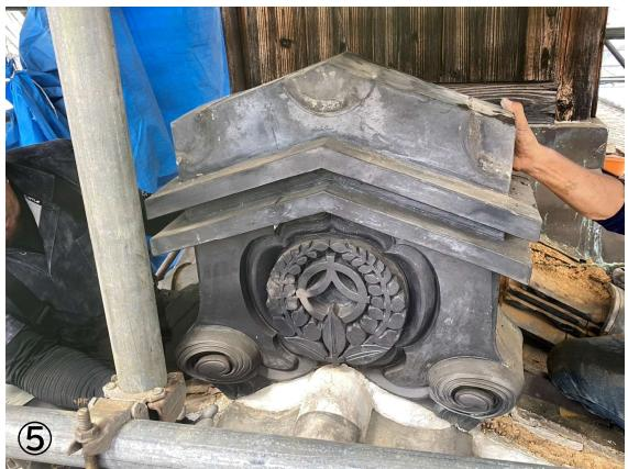
鬼瓦は6つのパートに分かれています。それぞれが太い銅線で結ばれ、屋根に固定されています。それらを外しながら、落とさないよう慎重に取り外していきます。
