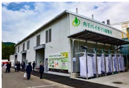
内子バイオマス発電所
