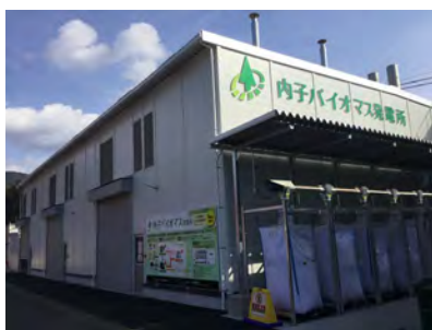
内子バイオマス発電所
