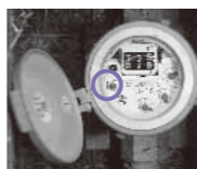
蛇口を閉めた状態で水道メーターの「O」の部分(パイロット)が回っていないか確認しましょう
