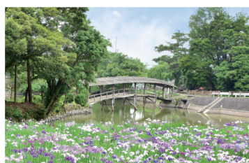
弓削神社屋根付き橋
