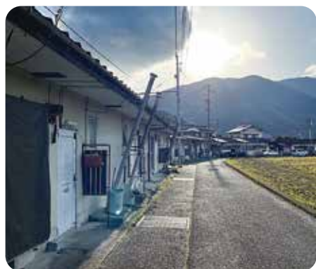
建替計画がある町営柿原団地
