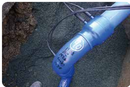
進んでいる配水管の耐震化工事
