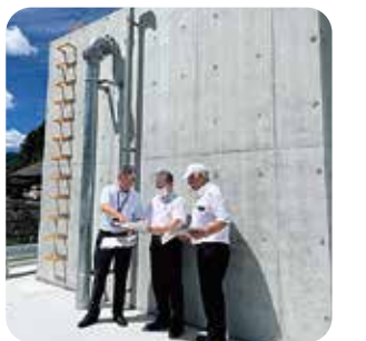
図面を確認しながらの工事監査
