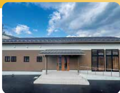
柿原自治会館新築工事8848万円
