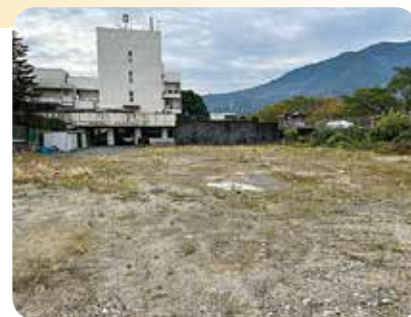
五十崎プール解体整地工事797万円
