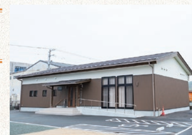
【柿原自治会館新築工事】 事業費：8,848万円
