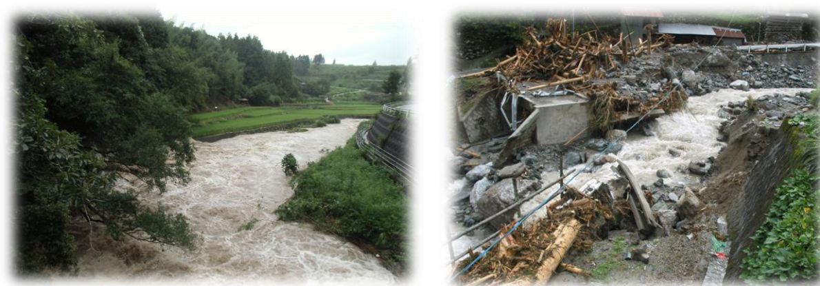
集中豪雨の様子【左】増水した河川 【右】破壊された橋と護岸
