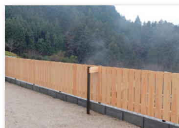
板塀の設置例
