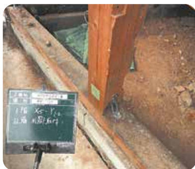
耐震化工事のようす
