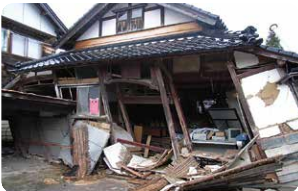
能登半島地震による倒壊した家屋
