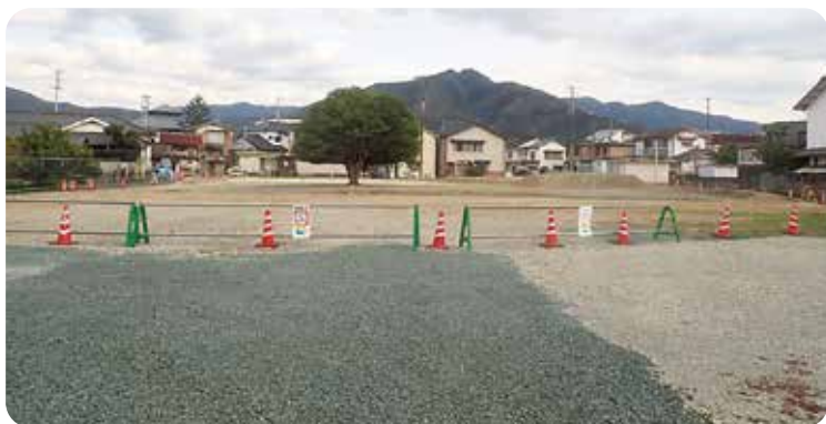
撤去工事が進む新川児童公園
