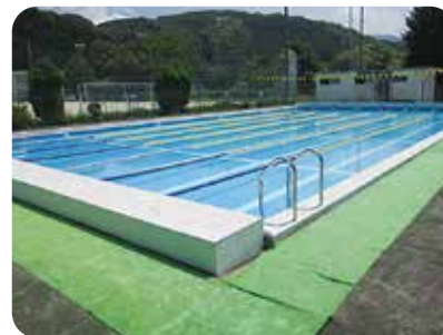
改修される五十崎小学校プール
