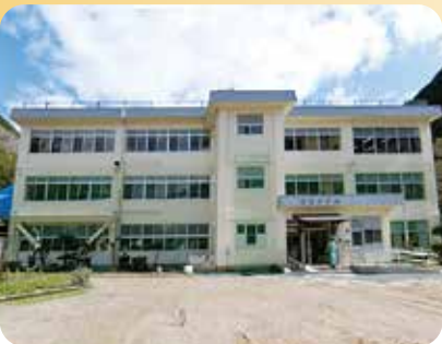
石畳小学校耐震補強改修建築工事 1億543万円
