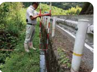
改良予定の今生地区水路
