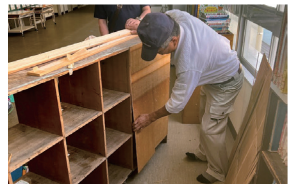
本棚の板を貼り直す作業（内子小学校）
