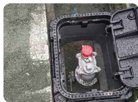
地上式を地下式に変更した消火栓
