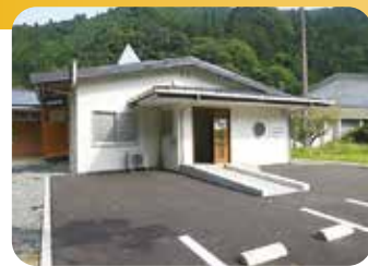
旧田渡幼稚園舎改修工事 事業費 6,112万円
