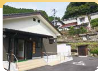
和田自治会館新築工事 事業費 7,481万円
