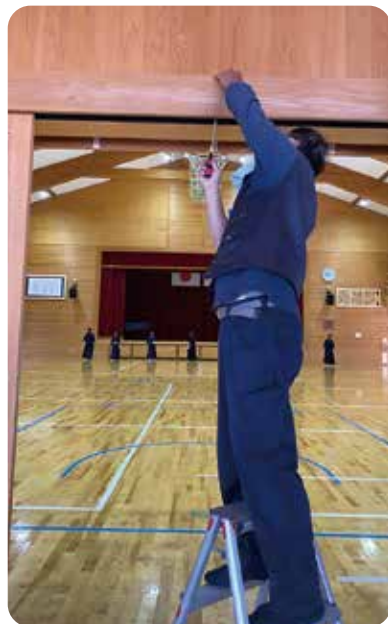
小田中学校体育館 扉調整
