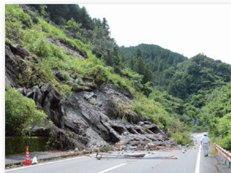
▲崩れ落ちた国道380号線の法面
