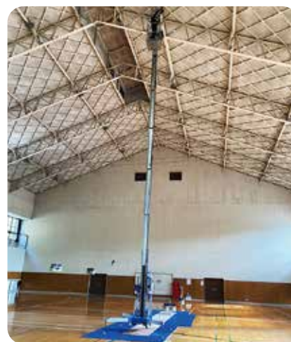
高所作業機械での照明施設の設置
