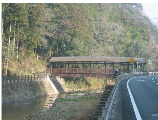
屋根付橋(鳥居元橋)
