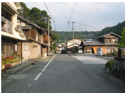
成留屋橋交差点付近
