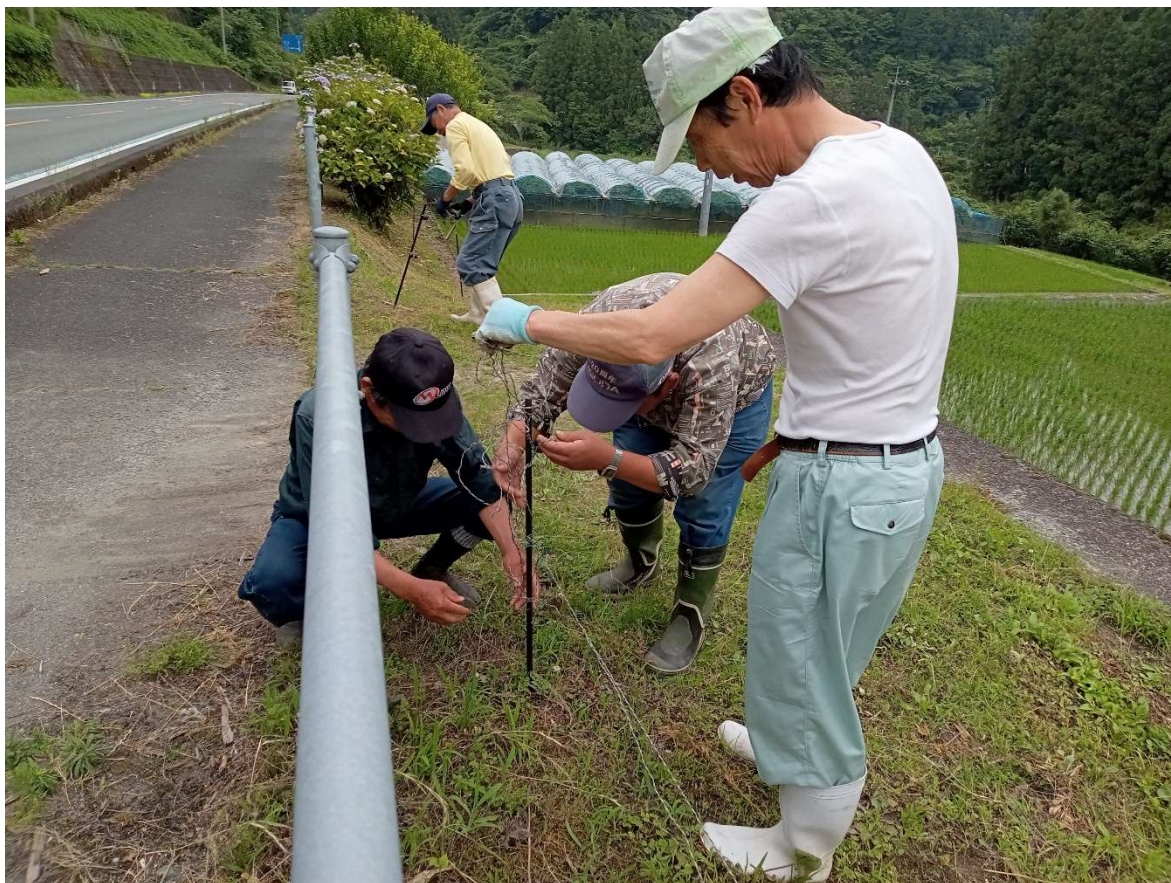
電気柵の設置
