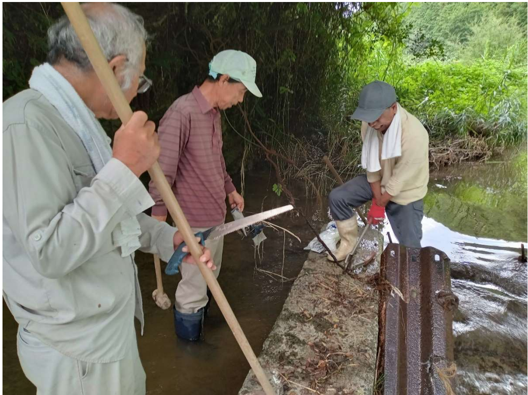
井出堰の作業中
