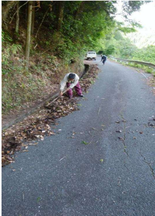
上井出水路清掃
