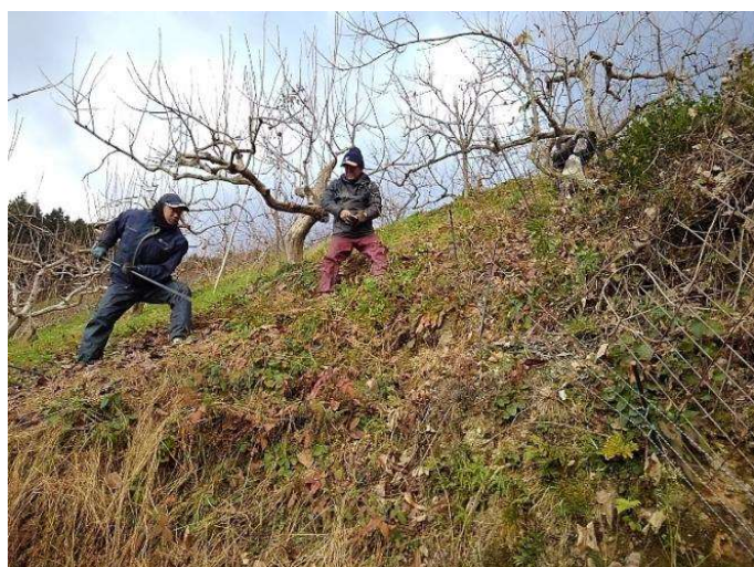
フェンスの設置作業
