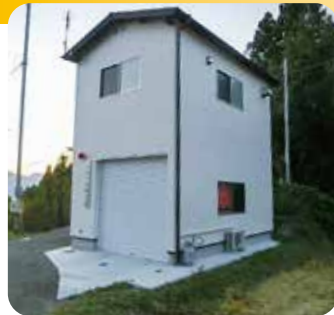
平岡4部詰所新築工事 1,026万円
