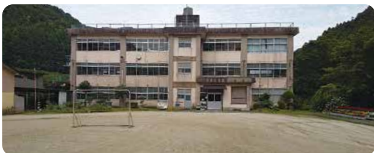
6月補正予算で、石畳小学校校舎の耐震補強設計委託費が予算計上された。このことについて、6月10日の本会議で質疑応答がなされた。
