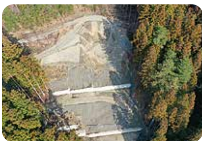
林道亀ヶ谷線災害復旧状況
