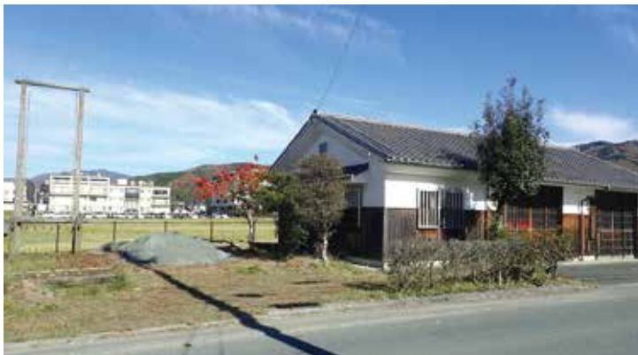
小田川堤防が越流した場合、天神地区で最初に浸かってしまう低い場所に建てられている「水防倉庫」
