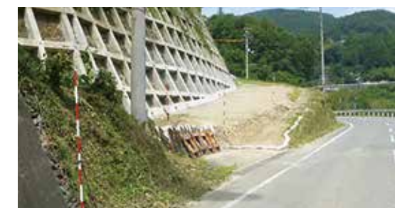
町道滝山線 道路改良予定地
