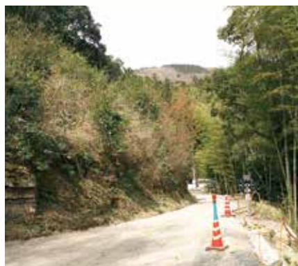
町道西横の地線 道路改良予定地
