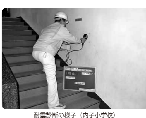
耐震診断の様子（内子小学校）
