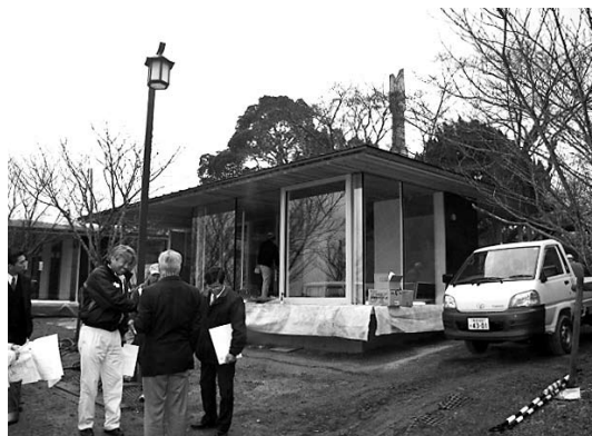
宿泊施設「オーベルジュ内子」の建設現場
