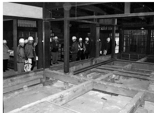
上芳我家主屋内の修理現場を視察
