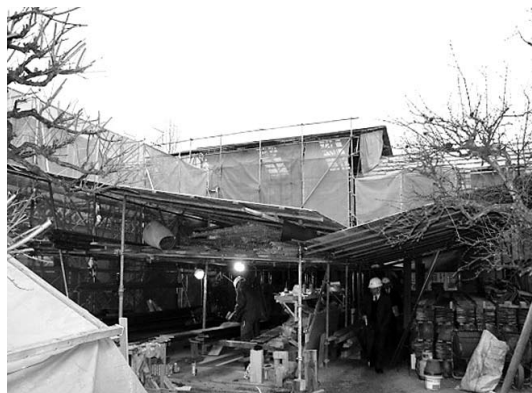
瓦1枚、柱1本まで、できる限り補修して再利用
