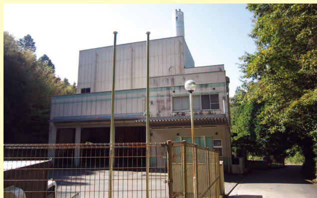
内子町クリーンセンター
