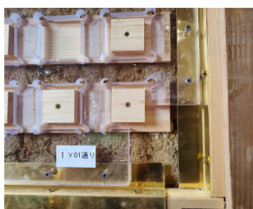
補強用ポリカ板取付の様子(9月14日撮影)
