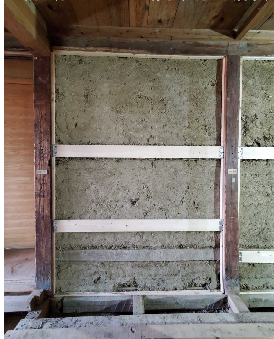
調整材が入った壁の様子(7月6日撮影)
