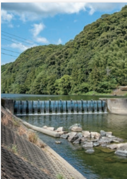
龍宮堰の様子
