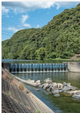
龍宮堰の様子
