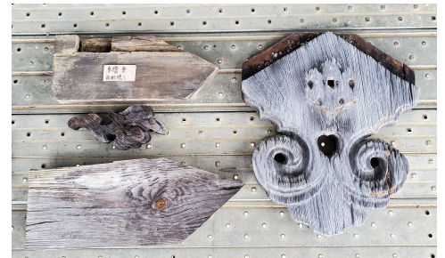
▲東櫓の懸魚及び桁隠し（上）と西櫓の懸魚及び桁隠し（左）。蕪懸魚と呼ばれる形をしている。
