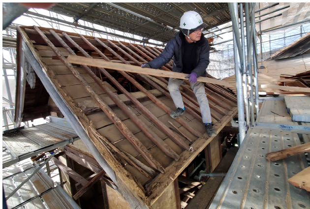
▲西檜の野地板解体の様子
