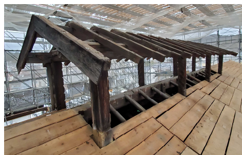
▲野地板解体後の太鼓櫓と骨組みとなった越屋根の様子
