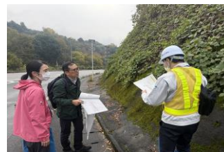
三者での施工内容の共有および現状確認
