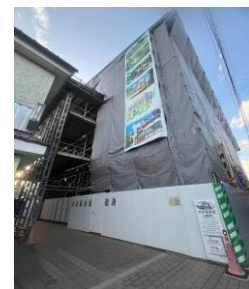
工事中の内子座
