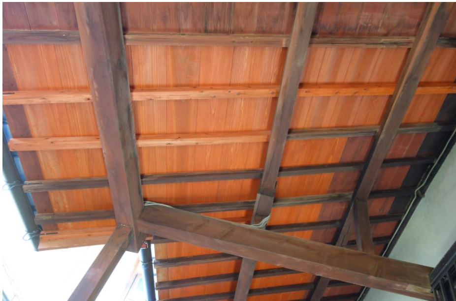
下地材(野地板)や垂木の修理実施による活用状況
