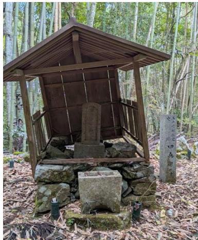
パトロール員の報告で判明した町史跡「四兵衛の墓」の危機的状況
