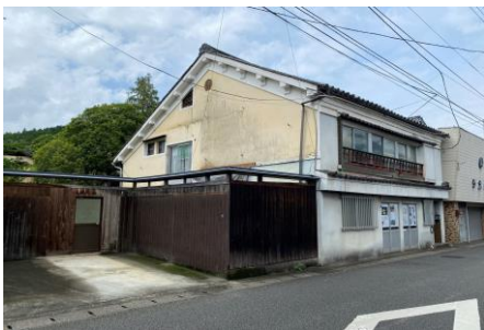
主屋改修前写真
