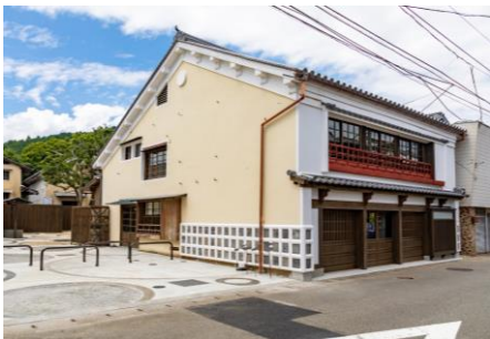
主屋改修後写真
