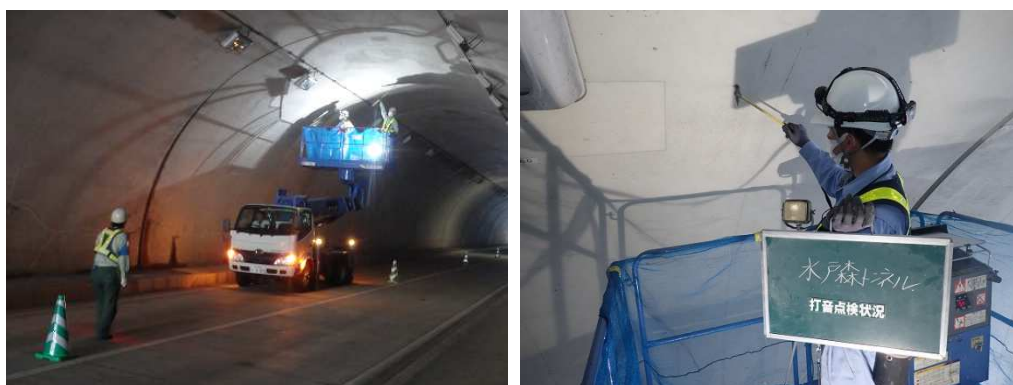
図2. 近接目視による点検状況
