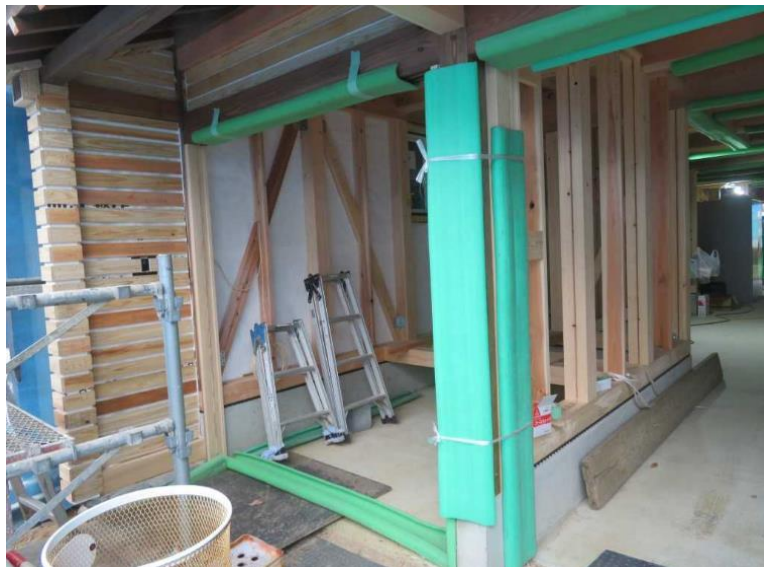
柱等構造材の状況
