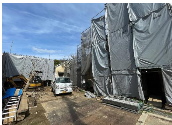
主屋・下土間・燃料蔵の3棟を工事中
