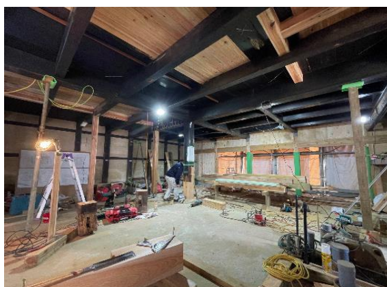
主屋内部の工事の状況
